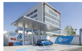
中規模 水素ステーション
